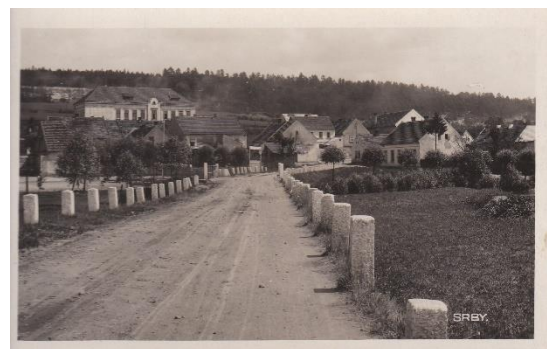
Srby - 1935 (Vjezd do Srb od Tuchlovic s mostem přes Kačák)
